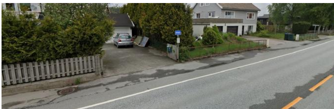
Figur 25. Dagens busstopp lengst sør, retning sentrum, ligger oppi to avkjørsler og gir en trafikkfarlig situasjon for brukere (Google maps, 2022).
